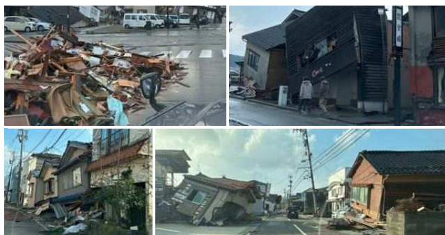
輪島市河井町の倒壊家屋群
